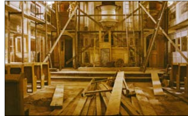
Links im Bild: Baustelle im Kirchenraum, 1970
